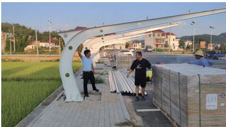
监督光伏车棚施工
